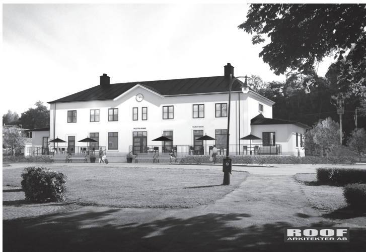
Det nyrenoverade stationshuset Lindesberg
