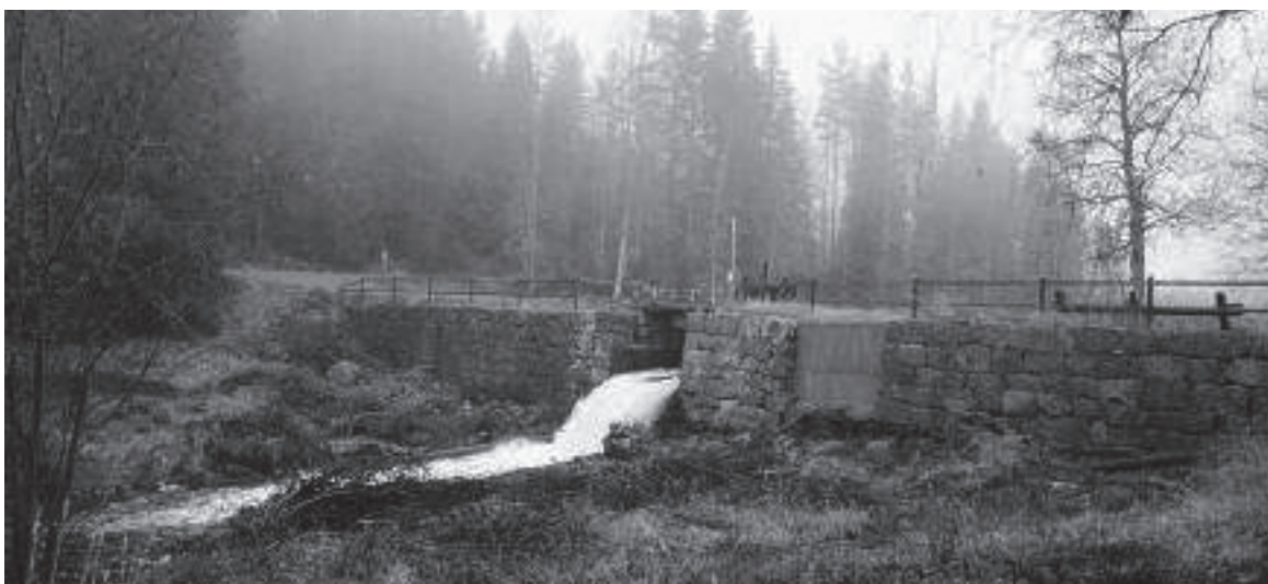
Dammen vid Korslångssmedjan
